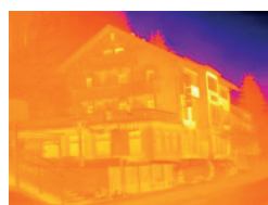
Épület hőképe testo SkálaAsszisztens nélkül
